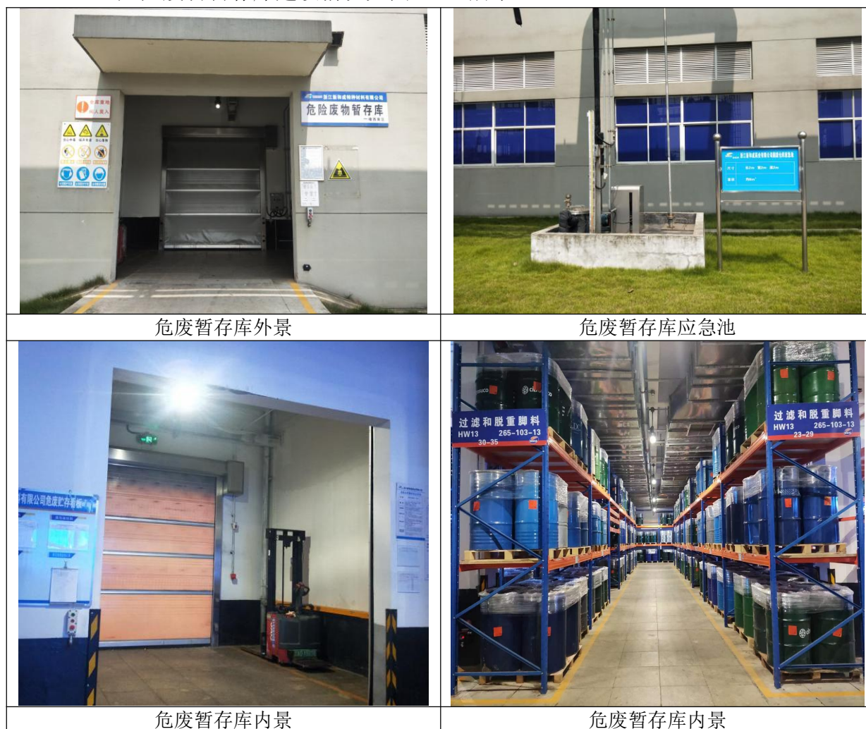
图 4.1-4 危废暂存库照片
